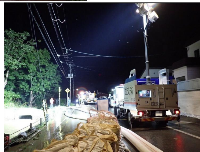
排水ポンプ車出動状況(幌延町)
