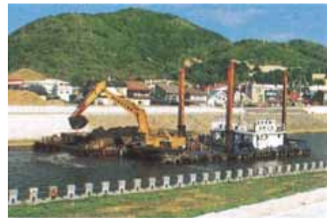
市街地下流地区掘削の例
