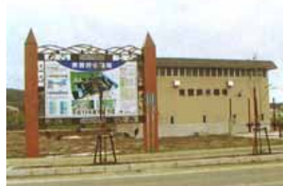
東雲排水機場 (H13完成)
