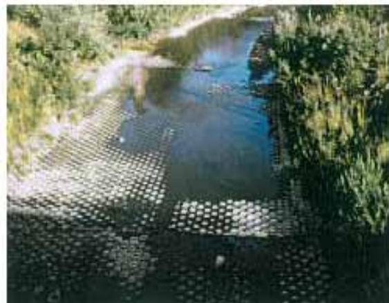
昭和59年8月湧水状況(幌糠水位観測所付近)
