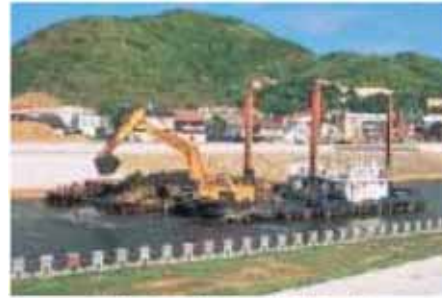
市街地下流地区掘削の例
