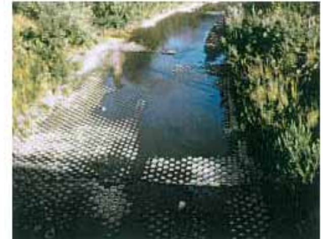
昭和59年8月湧水状況(幌糠水位観測所付近)
