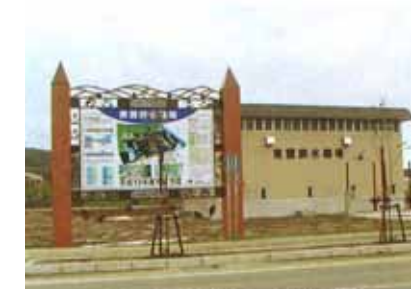
東雲排水機場 (H13完成)
