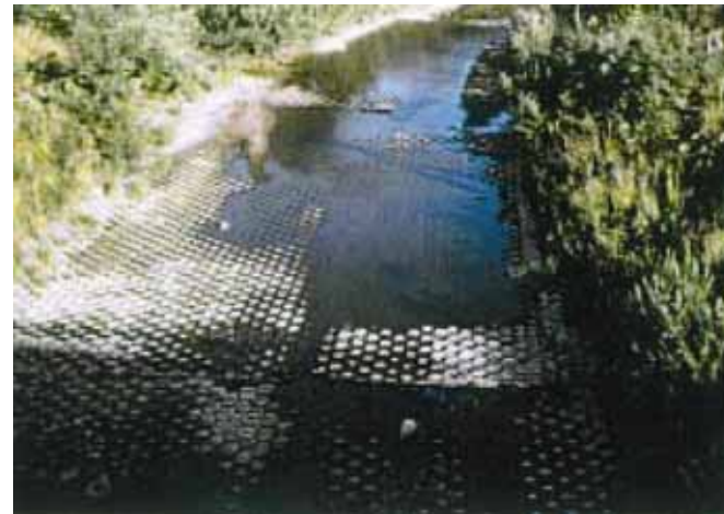
昭和59年8月湧水状況(幌糠水位観測所付近)
