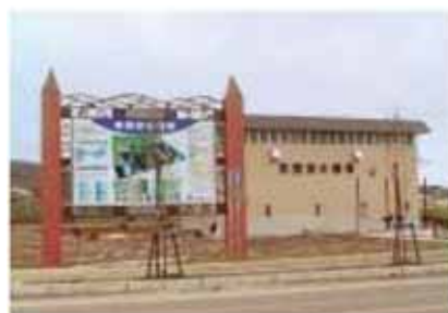
東雲排水機場（建設中）
