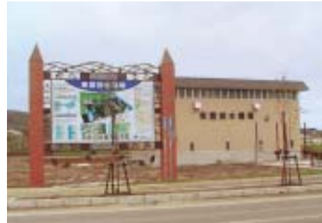
東雲排水機場（建設中）
