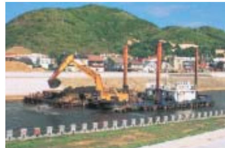
市街地下流地区掘削の例
