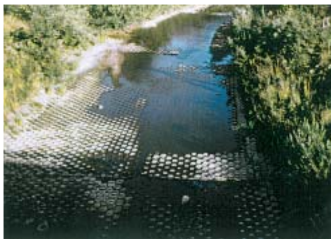
昭和59年8月濁水状況(幌糠水位観測所付近)
