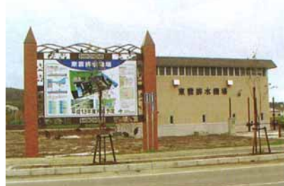
東雲排水機場 (H13完成)
