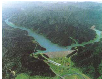
留萌ダム完成予想図(建設中)
