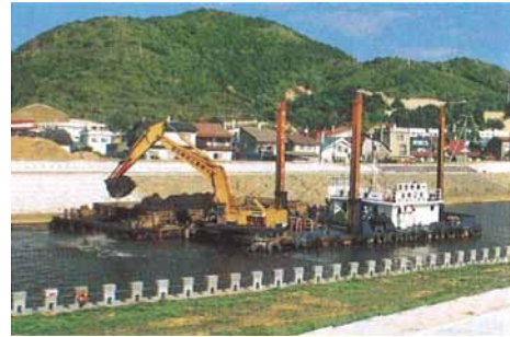
市街地下流地区掘削の例
