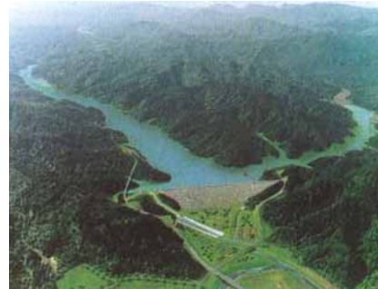
留萌ダム完成予想図(建設中)
