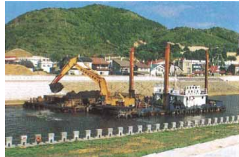
市街地下流地区掘削の例
