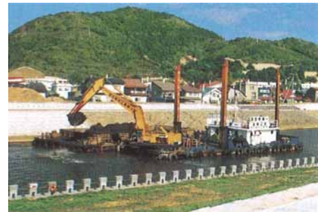
市街地下流地区掘削の例
