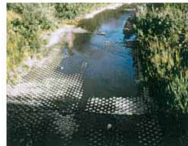
昭和59年8月濁水状況(幌糠水位観測所付近)
