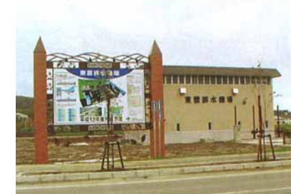
東雲排水機場(H13完成)
