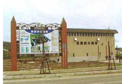
東雲排水機場(H13完成)
