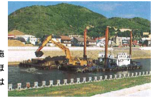
市街地下流地区掘削の例
