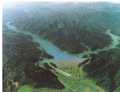
留萌ダム完成予想図(建設中)
