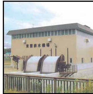
東雲排水機場
