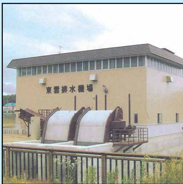
東雲排水機場
