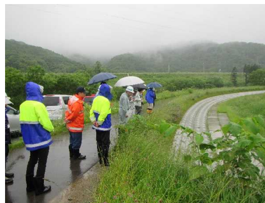
堤防裏法尻補強箇所の確認
