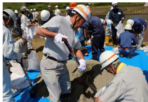
土のう製作実習
