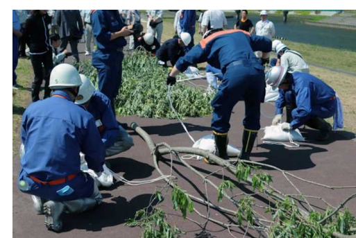
木流し工法実習
