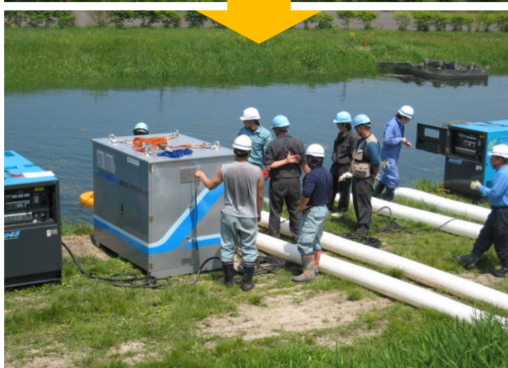
排水ポンプの設置状況
