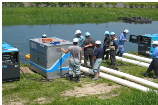
関係機関と連携した排水訓練
