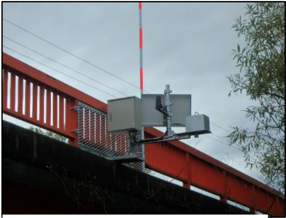
二十三号川葵橋(天塩町)
