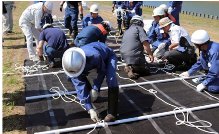
シート張り工法実習
