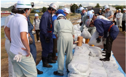
積土のう工法実習
