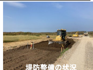
堤防整備の状況
