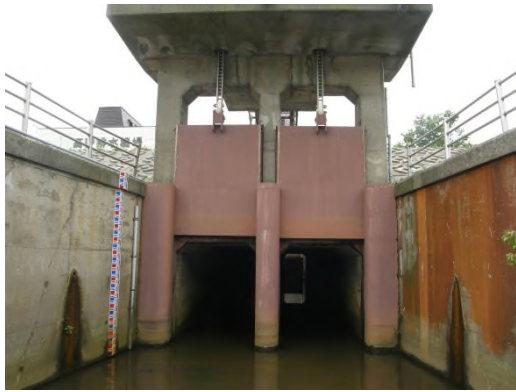
樋門の維持管理
