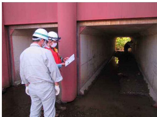
構造物の確認
