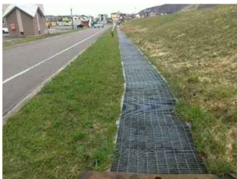
目的別巡視(堤内排水路の確認)
