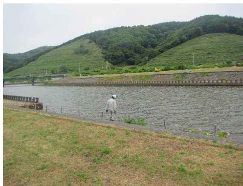
河道点検状況
