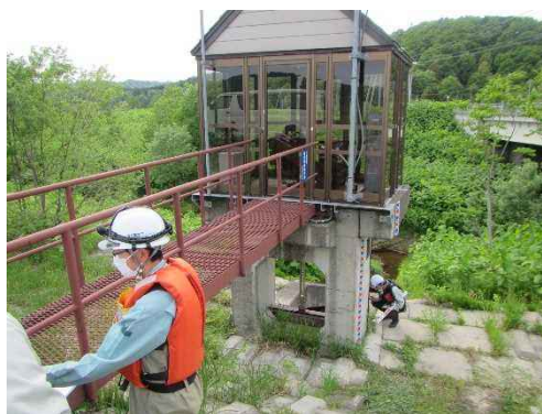
樋門点検の状況
