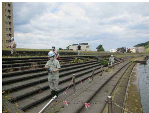
安全防止柵の点検
