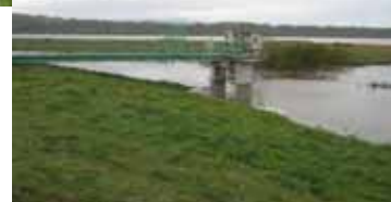
【平成18年10月出水における外水位状況】
