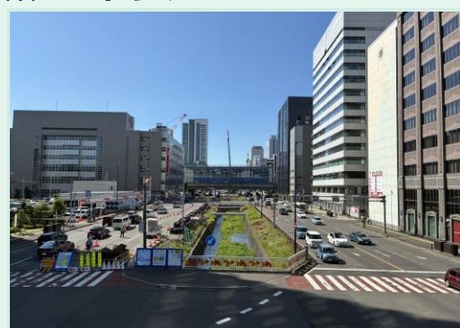
北8条函渠設置工事 8月定点写真
