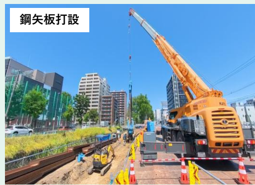
北9条函渠設置工事 8月現在
