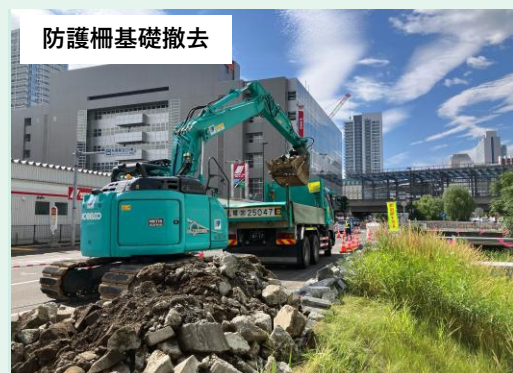
北8条函渠設置工事 8月現在
