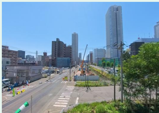
北9条函渠設置工事 8月定点写真
