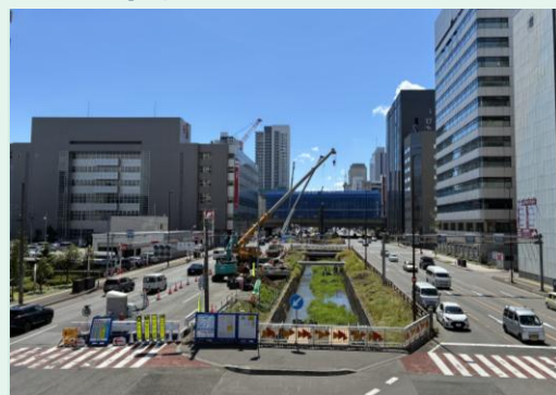
北8条函渠設置工事 9月定点写真
