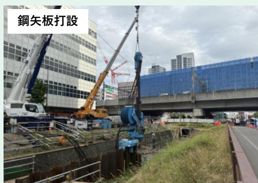
北8条函渠設置工事 9月現在
