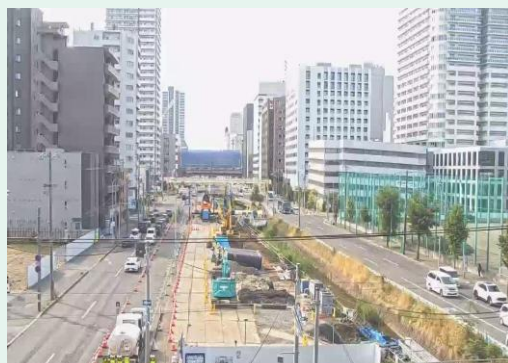
北9条函渠設置工事 9月定点写真
