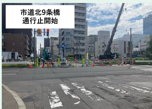
北9条函渠設置工事 9月現在
