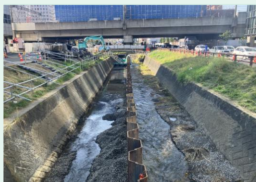
北8条函渠設置工事 仮河川施工
