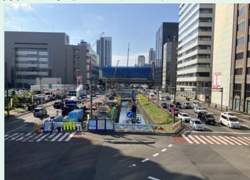
北8条函渠設置工事 定点写真
