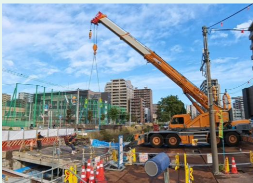
北9条函渠設置工事 市道北9条橋撤去
