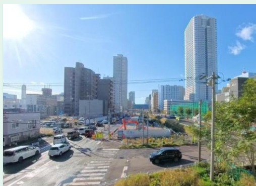
北9条函渠設置工事 定点写真
