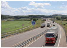
道央圏連絡道路
