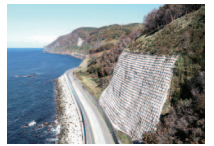
土砂災害防止対策（斜面対策の整備（石狩市））
