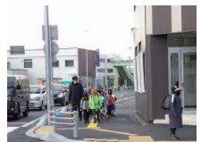
通学路における交通安全対策（防護柵設置）
