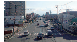
【整備前】国道12号 江別市
