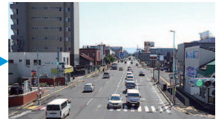
【整備後】国道12号 江別市
