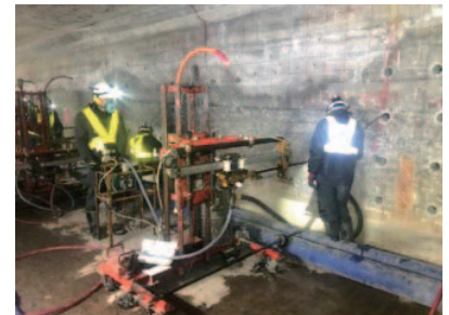
耐震補強による地下構造物の崩壊防止
