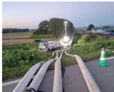
排水作業(排水ポンプ車、照明車)(江別市)
