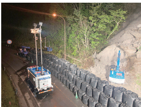
土砂除去状況(分解組立型バックホウ、照明車)(国道276号美笹峠)
