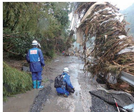
被災状況調査(熊本県芦北町)
