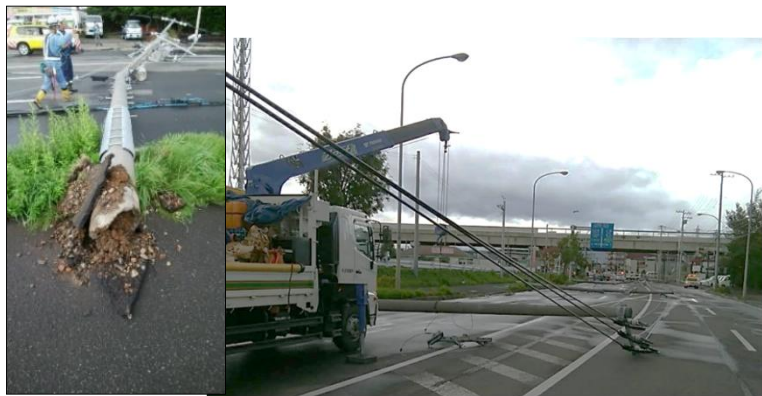
【台風の影響で電柱が倒壊(札幌市、国道275号)】
