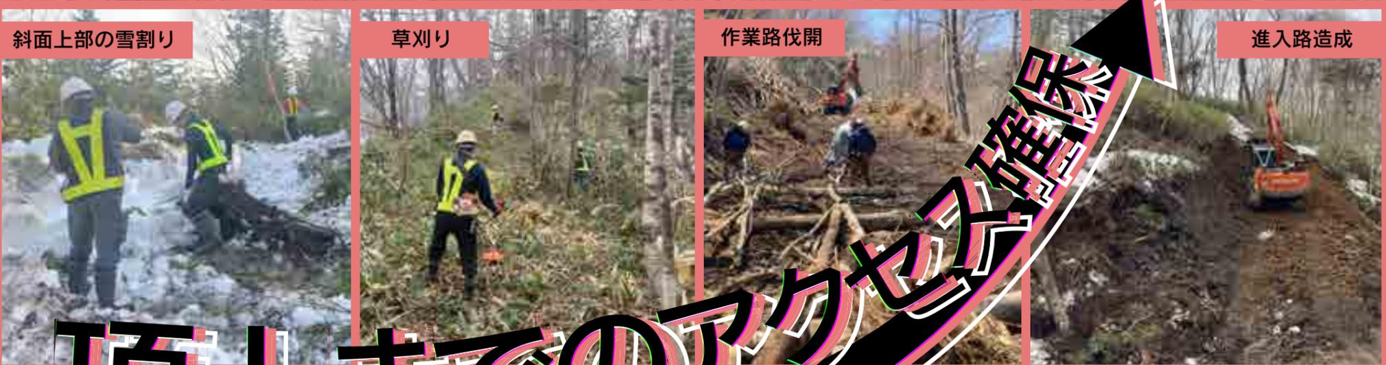
法面上部に残る不安定岩塊を除去するために必要なアクセスルートの整備、岩体上部に堆積した表土除去が急ピッチで進めた。
