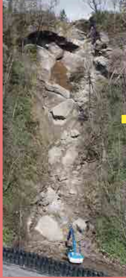
岩塊除去の進捗状況
