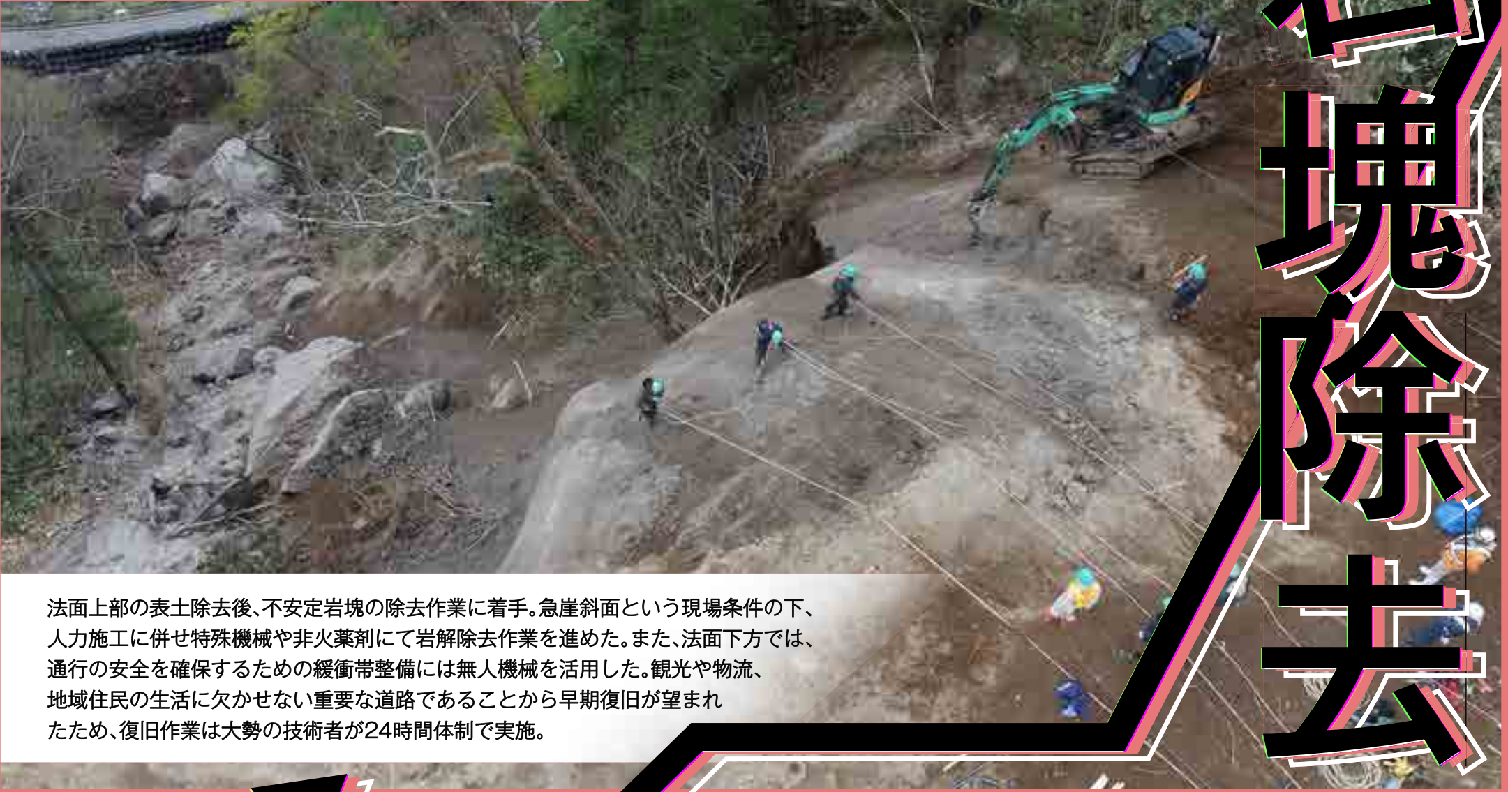
特殊機械(クライミング機械)と人力を併用した破碎作業
