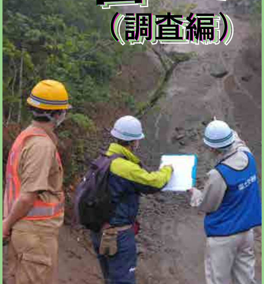
有識者による斜面調査
