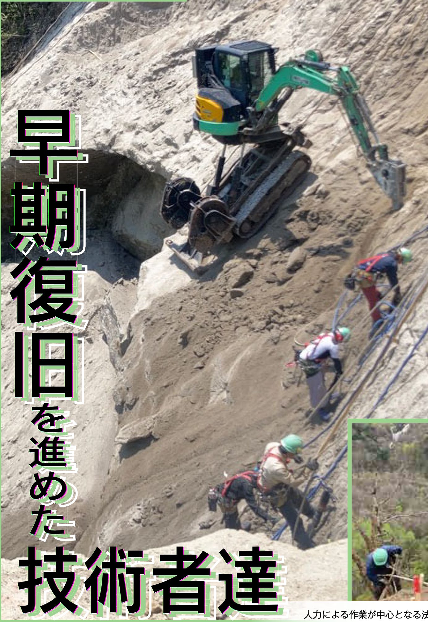
特殊機械と人力の併用による破碎作業
