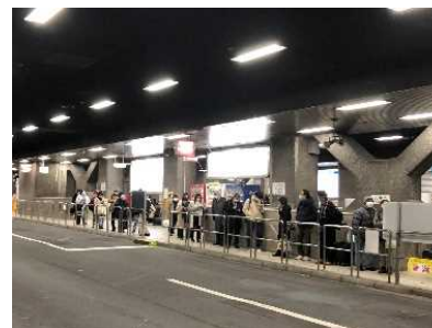
寒風等が吹き込む乗降場
