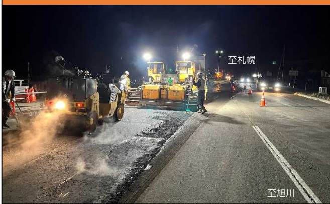
【写真③】 光珠内工区 桃橋(ボックスカルバート)設置のための仮道舗装状況
