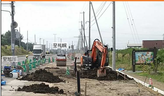
【写真③】 光珠内工区 桃橋(ボックスカルバート)設置のための仮道舗装状況
