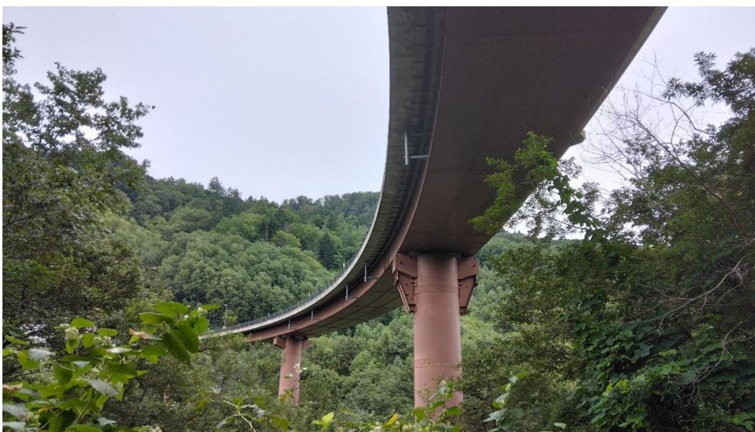
橋脚（定山溪側から中山峠側を望む）
