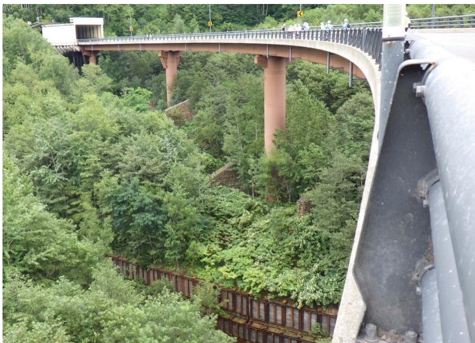
外観（定山溪側から中山峠側を望む）
