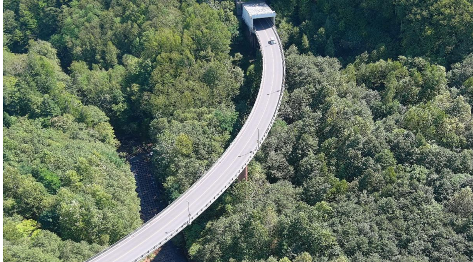
外観（俯瞰）（定山溪側から中山峠側を望む）
