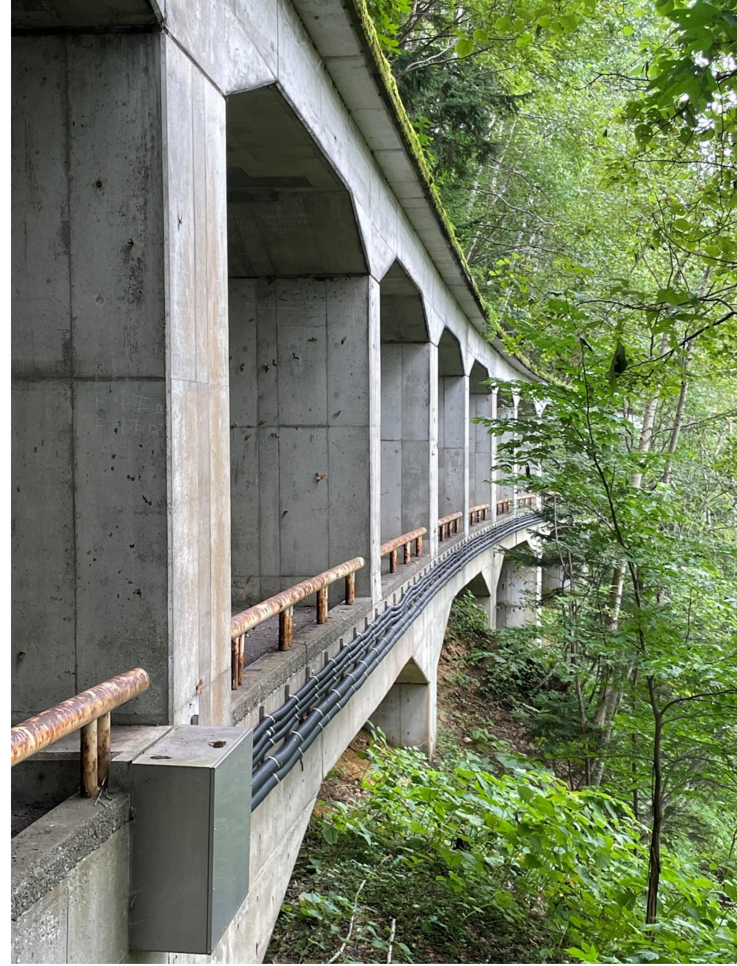
外観（中山峠側から定山溪側を望む）
