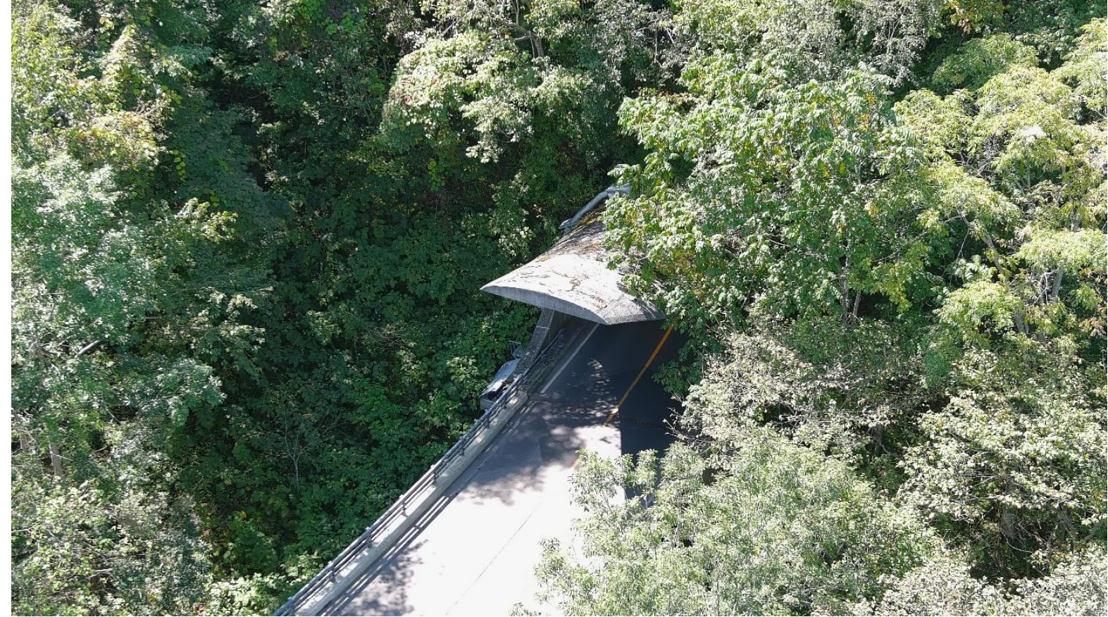
坑門工外観（俯瞰）（中山峠側）
