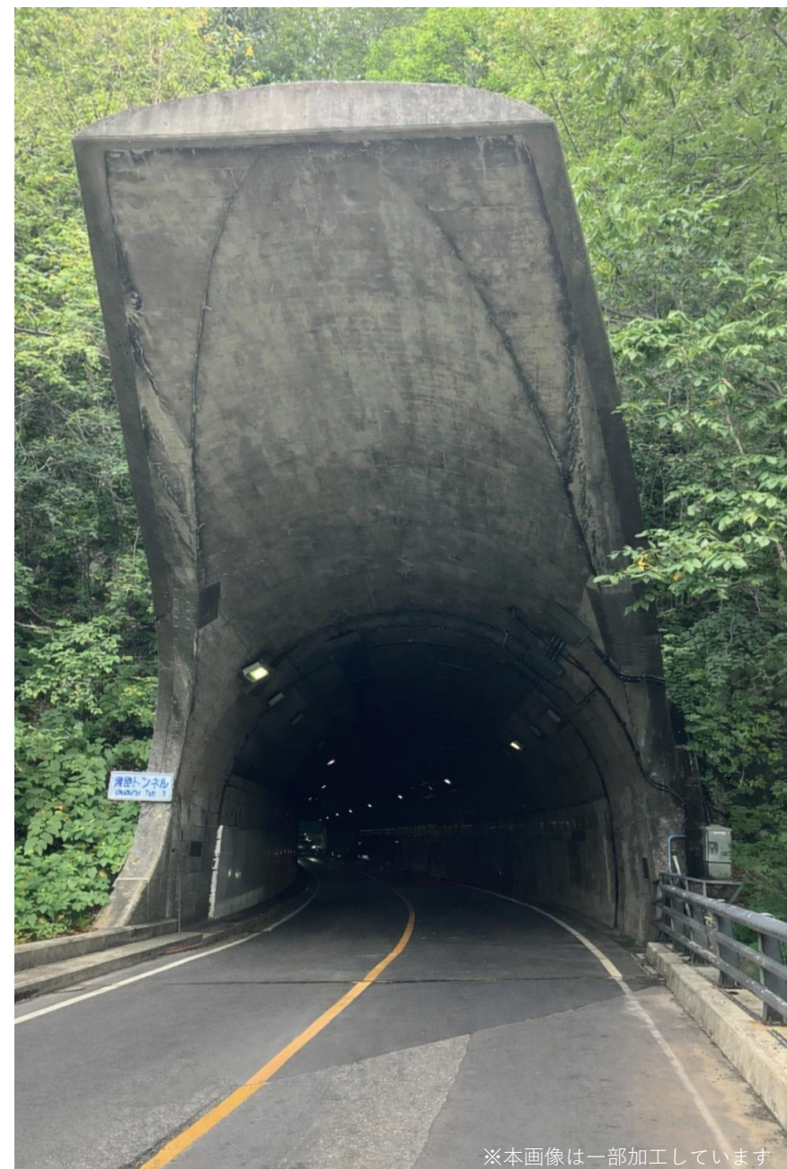
坑門工外観正面 （中山峠側）
