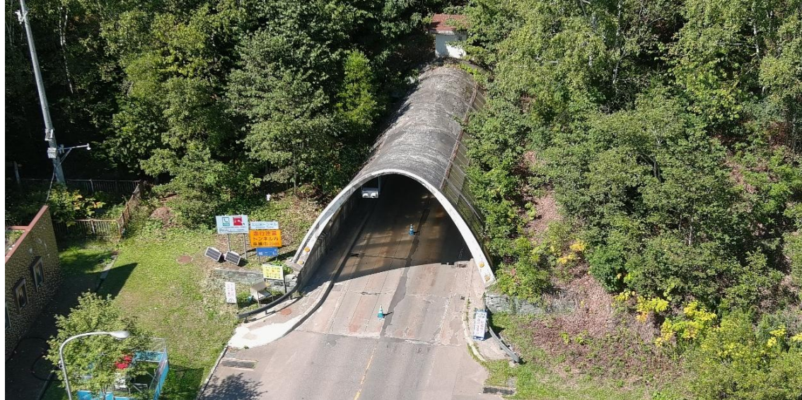
ルーバー外観（俯瞰）（中山峠側）
