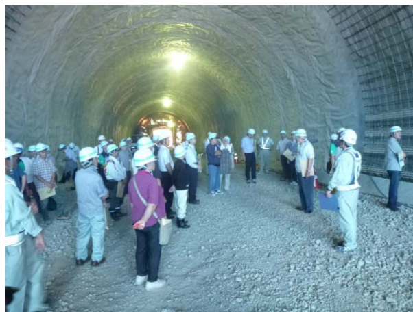
見学状況（トンネル坑内）
