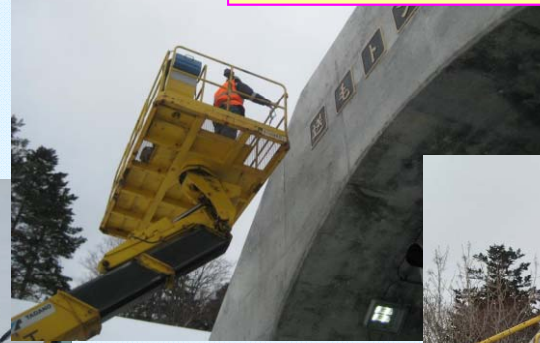
高所作業車に乗り、トンネル銘板を設置し喜んでいました。
