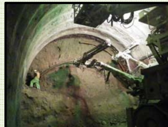
鋼製支保工建て込みドリルジャンボ
