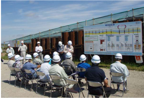
工事に関する説明
