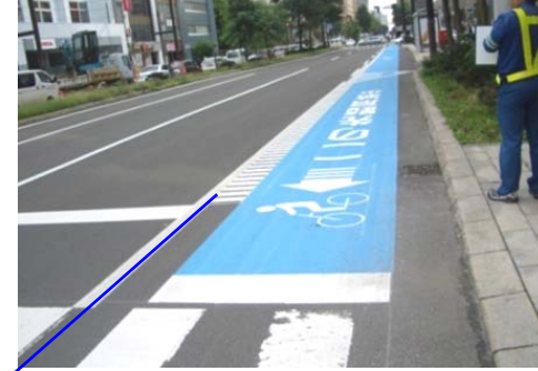
【ランブルストリップス+停止線の前出しによる左折巻き込み防止対策】
