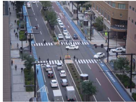
【実験区間状況写真】
