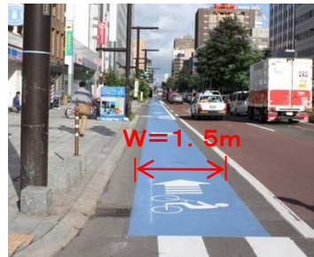
【ブルーレーンの設置状況】
