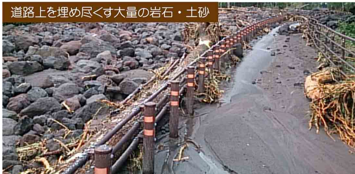
道路上を埋め尽くす大量の岩石・土砂
