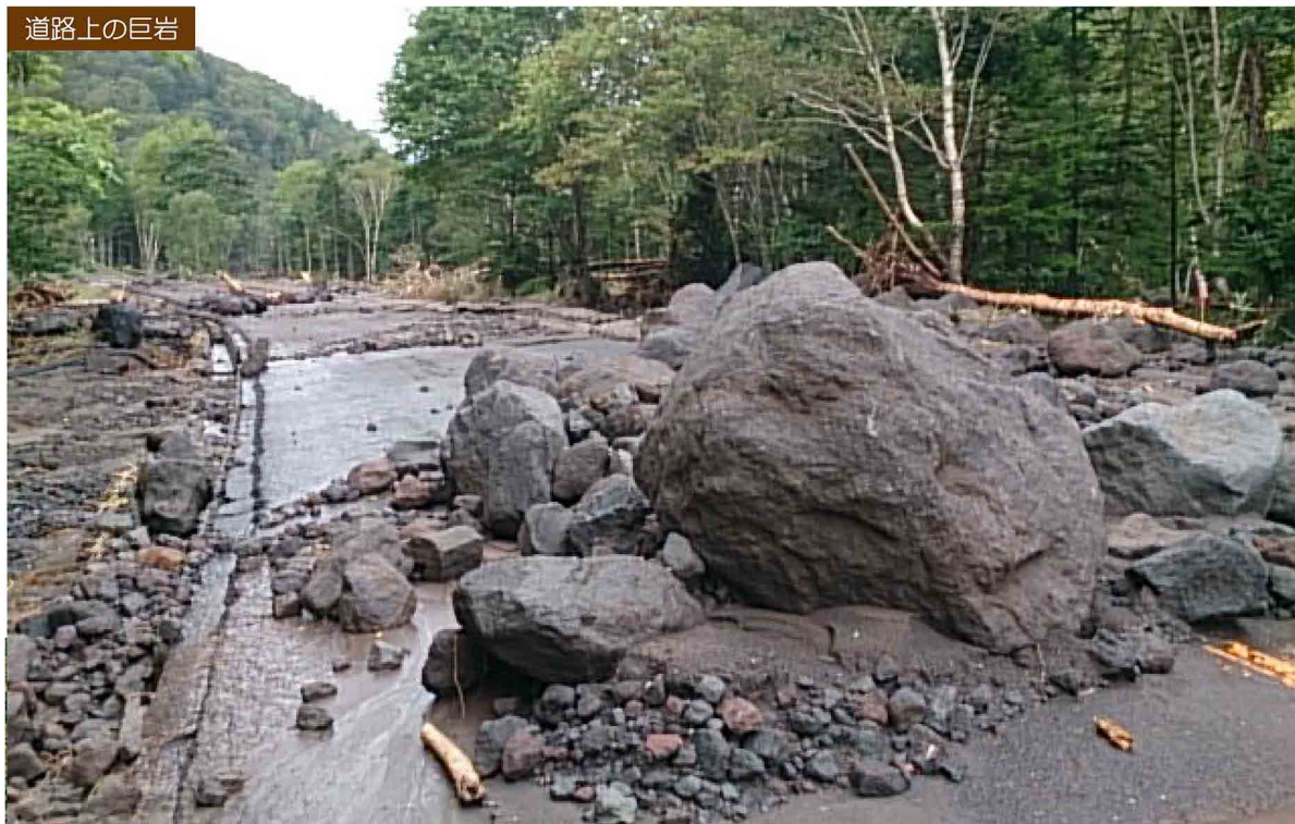
道路上を埋め尽くす大量の岩石・土砂
