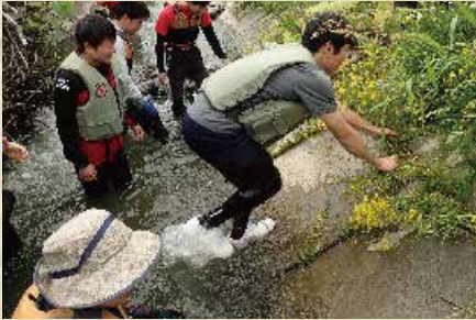
「ブロックの滑り」を確認
