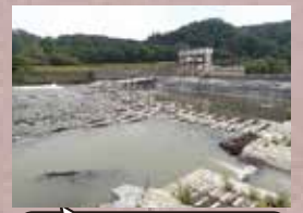
栗沢頭首工（下に魚道入口）
