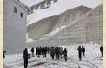
ダム直下で堤体を仰ぐ
