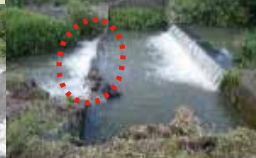
↑完成した魚道
