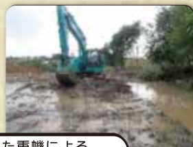
前日まで行われた重機による砂利投入の様子
