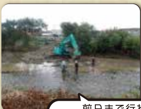
前日まで行われた重機による砂利投入の様子
