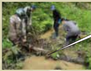
倒木を利用した床止め作業
