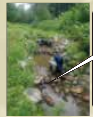
床止めの石組み作業
