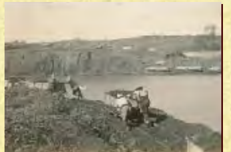
夕張川掘削 人力によるトロロコでの土砂運搬作業 (写真：石狩川開発建設部札幌河川事務所蔵)
