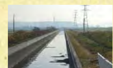
揚水された水が流れる水路
