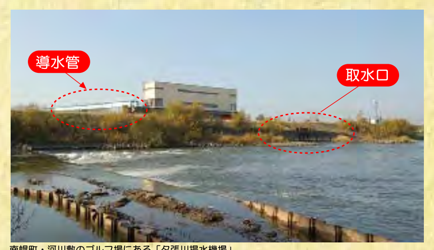
南幌町・河川敷のゴルフ場にある「夕張川揚水機場」
