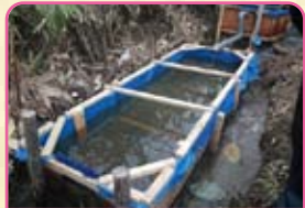
完成したプール 沢水を取り入れてます。
