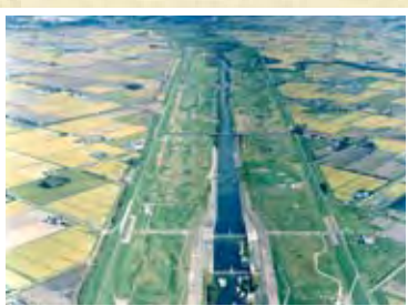
夕張川河口方向から見た新水路
