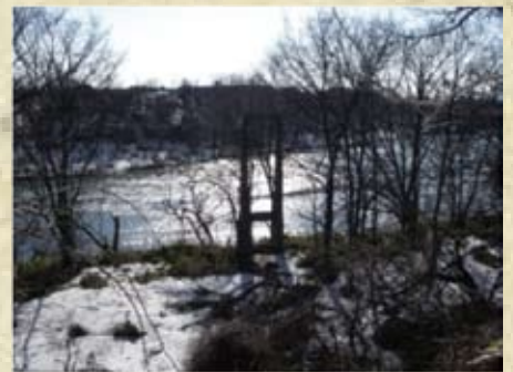
吊り橋の橋脚と思われる構造物
