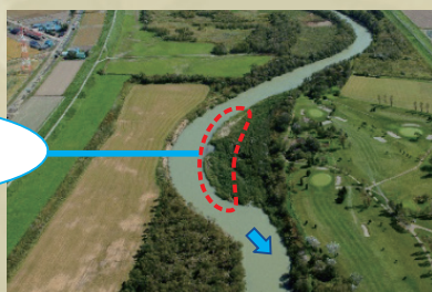
伐根掘削箇所
