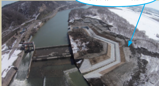
栗沢頭首工の魚道
